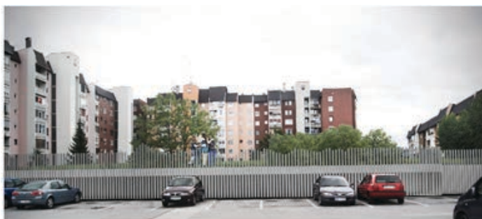
Ureditev zaščitne ograje nad garažo C
