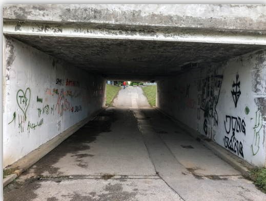
Podhod pod Cesto Jaka Platiše.
