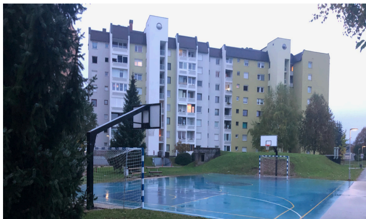
Obnovljeno športno igrišče
