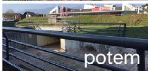
Obnova in barvanje ograje podhoda do trgovine Spar.
